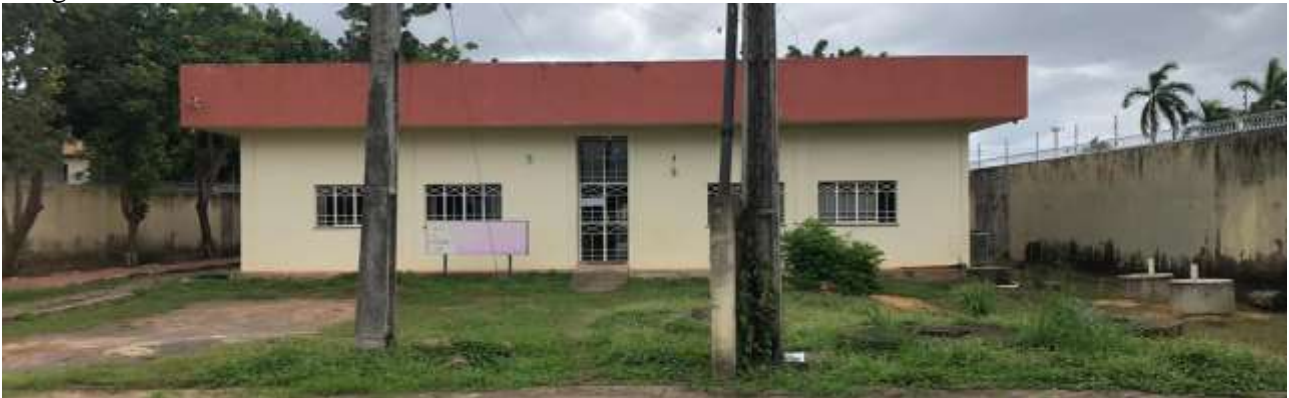
Imagens do local- Prédio
