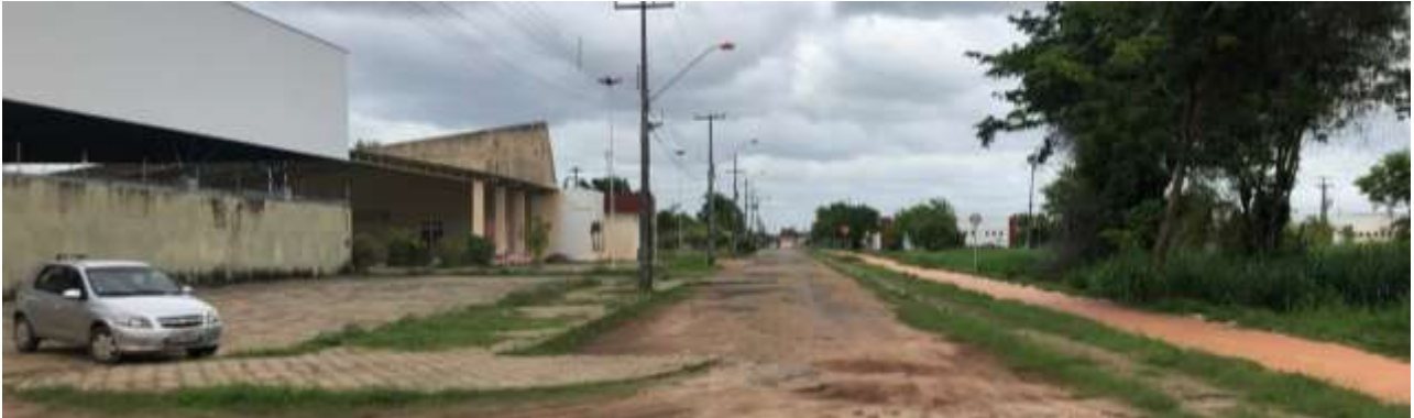
Imagens do local- Rua de acesso
